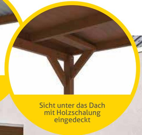
Sicht unter das Dach mit Holzschalung eingedeckt
