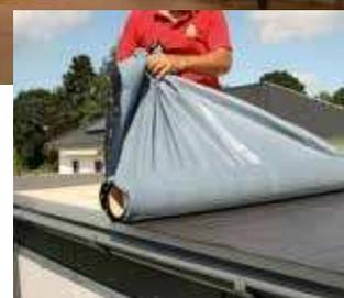
Selbstklebende Bitumen-Dachbahn mit Aluminium-Oberschicht
