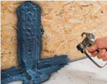
Luftdichtes Übersprühen von Befestigungswinkeln,
