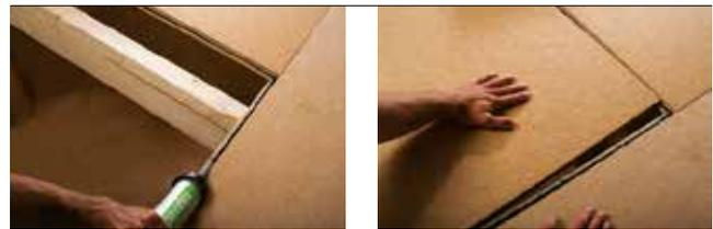
Abb. 1 Verkleben der Plattenstöße
