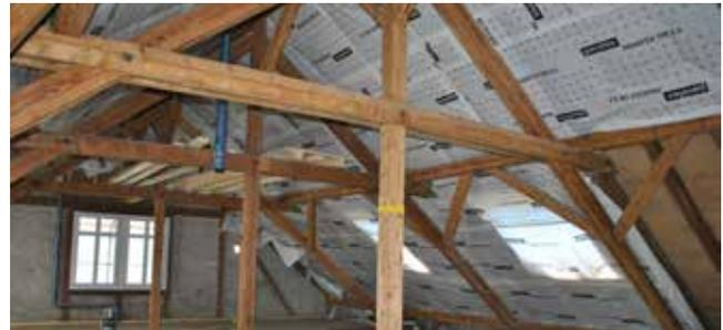
Bei der Errichtung von Gebäuden (insbesondere in Massivbauweise) werden erhebliche Mengen an Wasser für die Aufbereitung von Beton, Estrich, Putz usw. benötigt. Hinzu kommt, dass die eingedrungene Niederschlagsfeuchtigkeit während der Bauphase kaum zu kalkulieren ist. Diese Feuchtemengen entweichen durch Trocknung aus den Bauteilen und diffundieren u. a. durch die Dachkonstruktion. Das ist bei der Planung des Bauablaufs zu berücksichtigen.
