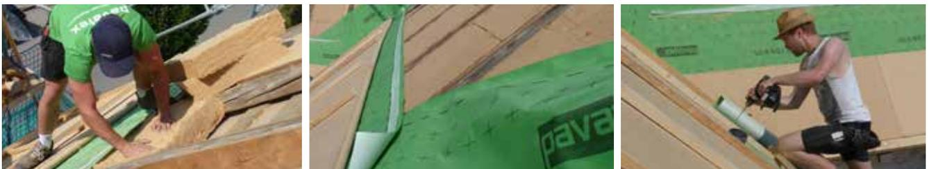
Abb. 17 Dachsanierung von außen ohne Beeinträchtigung des Innenraums.
