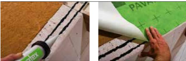
Abb. 18 Verkleben Anschlüsse und Bahnen
