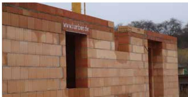
Abb.3 Winterbaustelle mit starkem Feuchteeintritt im Ziegelmauerwerk
