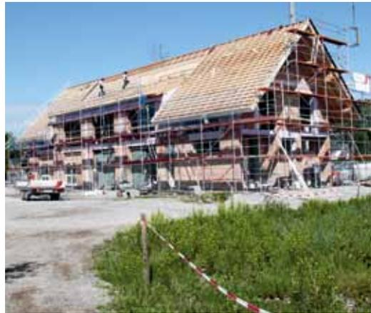
*Eine typische Aufsparrendämmung vollflächig und einfach realisiert in Legau, D.*
