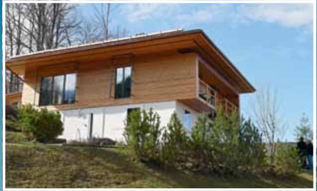
*Im österreichischen Bad Dürrenberg wurde ein Haus modernisiert und mit einer Holzfassade versehen. Um die Substanz energieeffizient zu dämmen, wurden PAVATEX Holzfaserdämmstoffe verwendet.*
