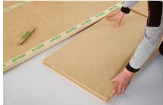
*PAVATHERM-PROFIL ist die druckbelastbare, schalldämmende Holzfaserdämmplatte für den Fussbodenbau.*
