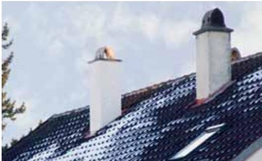
*Ein optimal gedämmtes Dach hingegen hat an der Aussenseite die gleiche Temperatur wie die Umgebung, so dass der Schnee auf dem Dach liegen bleibt.*
