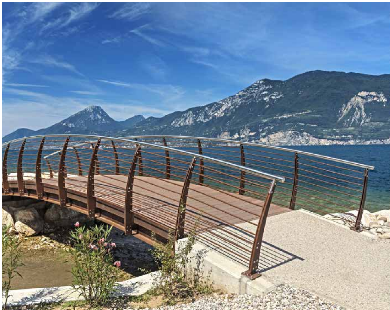
Brücke am Gardasee, DIE KOMPAKTE in Braun
