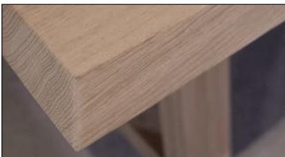
alle vier Seiten nach außen abgeschrägt
