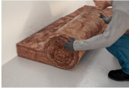
In einer Raumecke beginnen und die Universaldämmrolle Classic 035 lose auf der Obersten Geschossdecke verlegen. Die Verlegung erfolgt Stoß an Stoß.
