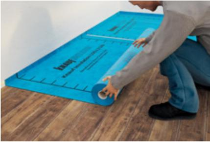
Zunächst wird die Dampfbremse LDS 2 Silk verlegt. Die Überlappungen werden mit dem Haftklebeband LDS Soliplan verklebt. Der Wandanschluss erfolgt mit der LDS Solimur.
