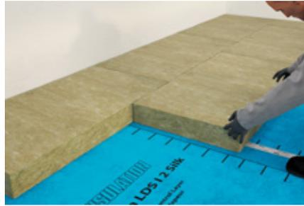
Mit der Verlegung in einer Raumecke beginnen und lose auf der Dampfbremse im Verband verlegen (Versatz  $\geq 10$  cm).
