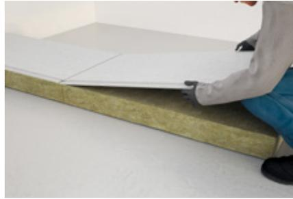
Als Gehbelag und zum Schutz der Dämmung wird ein Fertigteil Estrich (z. B. Knauf Brio 18) oder Spanplatten auf der Dämmung verlegt.
