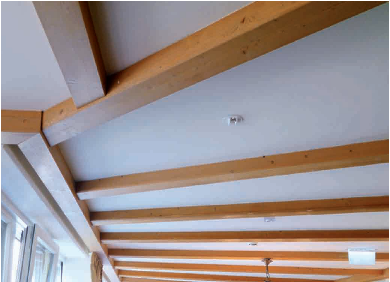
Fichte Deckenbalken – gefaste Kantenausführung – gebürstete Oberfläche
