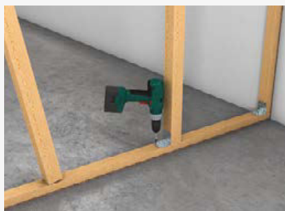
Montage der Holzständer mit Stiftnagel oder Stahlwinkel
