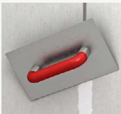
Fugen und Befestigungsmittel verspachteln
