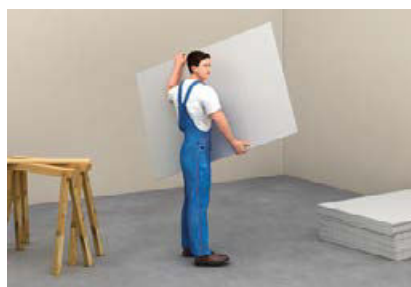
Einzelne fermacell® Gipsfaserplatten hochkant tragen
