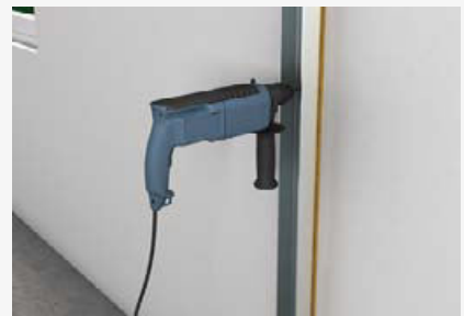
Befestigung der CW-Profile an Massivwand auf Dämmstreifen
