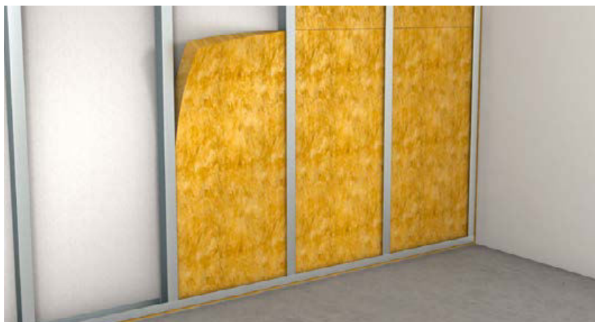
Einbringen der Dämmstoff-Platten
