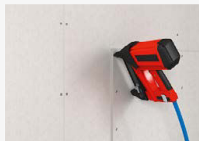
Klammern fermacell® Gipsfaserplatte auf fermacell® Gipsfaserplatte (unterkonstruktionsneutral)
