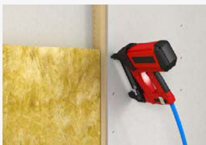
Klammern auf Holzunterkonstruktion
