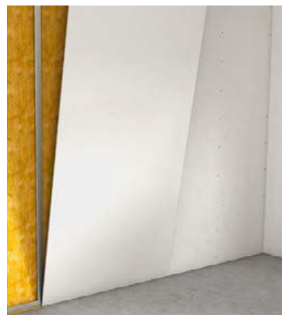
Bekleidung der Metallunterkonstruktion
