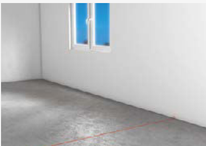
Anlegen der Wandachse mit Schnurschlag oder Hochbaulaser
