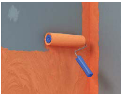
Abb. 7: Sicherstellung der Abdichtung für die Wassereinwirkungsklasse W1-I und W2-I. fermacell™ Flüssigfolie mit der Rolle mind. 2 x vollflächig auftragen (Trockenschichtdicke mindestens 0,5 mm). Gemäß DIN 18534-3 wird für den 2. Auftrag ein Farbumterschied zur besseren Nachvollziehbarkeit gefordert. 1. Auftrag: fermacell™ Flüssigfolie in Originalfarbe satt auftragen und trocknen lassen
