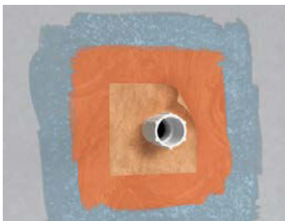
Abb. 4+5: Zur Abdichtung von Rohrdurchführungen die fermacell™ Wanddichtmanschette in die noch feuchte fermacell™ Flüssigfolie einbetten und direkt erneut überstreichen – Trocknungszeit mind. 1 Stunde
