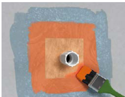
Abb. 4+5: Zur Abdichtung von Rohrdurchführungen die fermacell™ Wanddichtmanschette in die noch feuchte fermacell™ Flüssigfolie einbetten und direkt erneut überstreichen – Trocknungszeit mind. 1 Stunde
