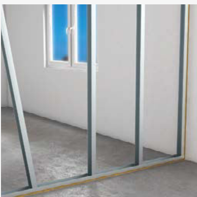
Montage der CW-Ständerprofile
