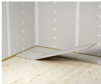
5 Verkleben der Elemente mit vollständig gefüllten Fugen
