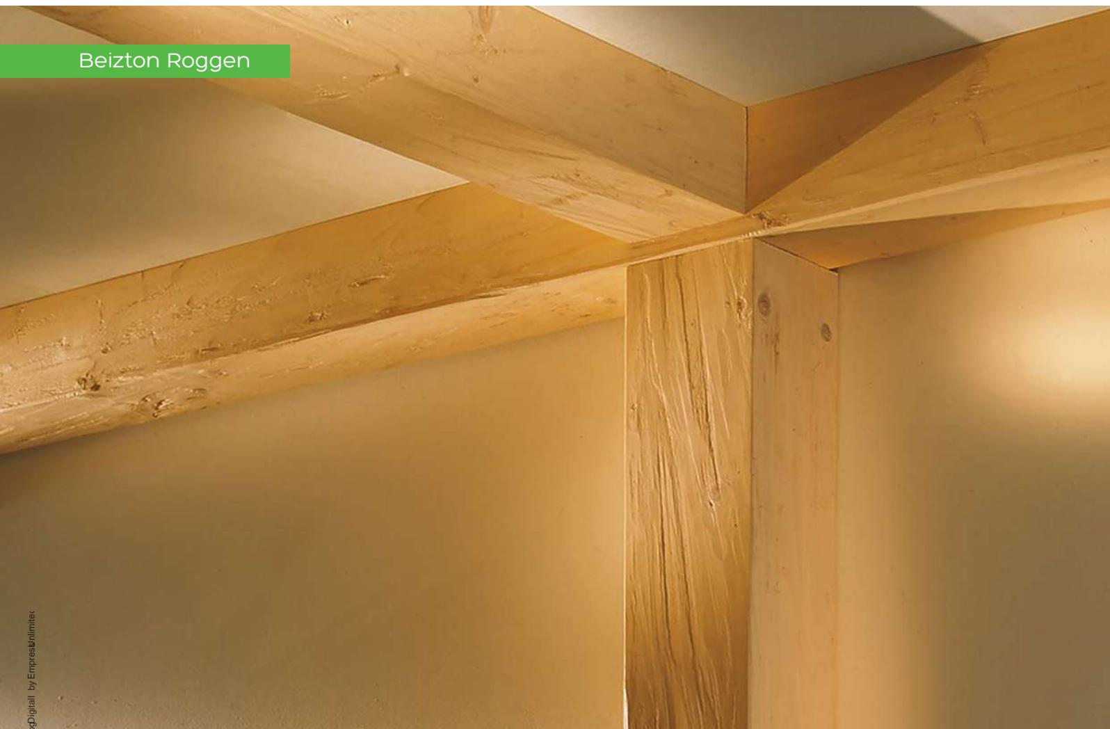
Die Burgdecke ist eine traditionelle Stürzerdecke - ein Klassiker für behagliches Wohnen. Durch ein Standard Nut | Feder - System ist die Montage schnell und einfach.
