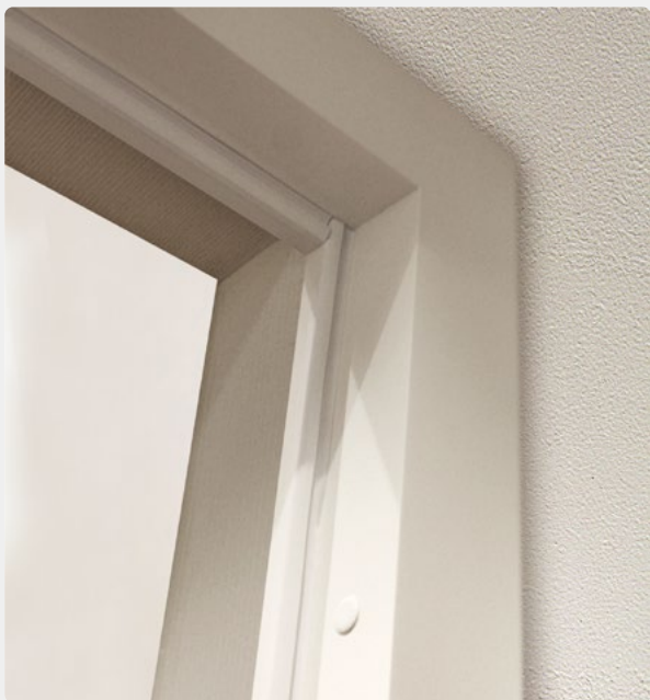
Blendrahmen auf der Wand
