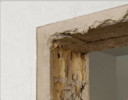
Die Wand nach dem Entfernen der alten Zarge.
