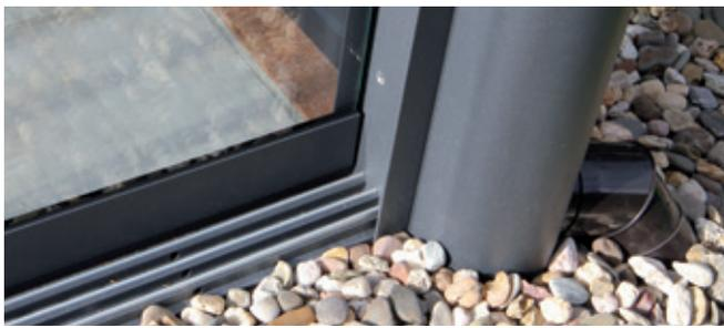
**Passgenauigkeit:** Ganzglas-Schiebeanlagen fügen sich perfekt ein, der Regenabfluss ist in die Stütze integriert.
