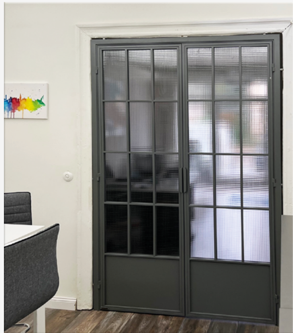
Drehtür 2-flg. in vorhandene Altbau-Zarge verbaut
