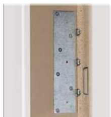
verstärktes Schließblech mit Stahlhalteplatte Nr. 35 Ansicht Futterrückseite
