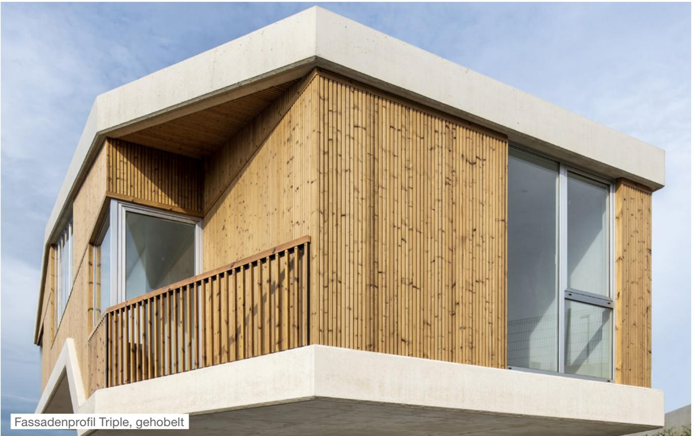
Fassadenprofil Triple, gehobelt
