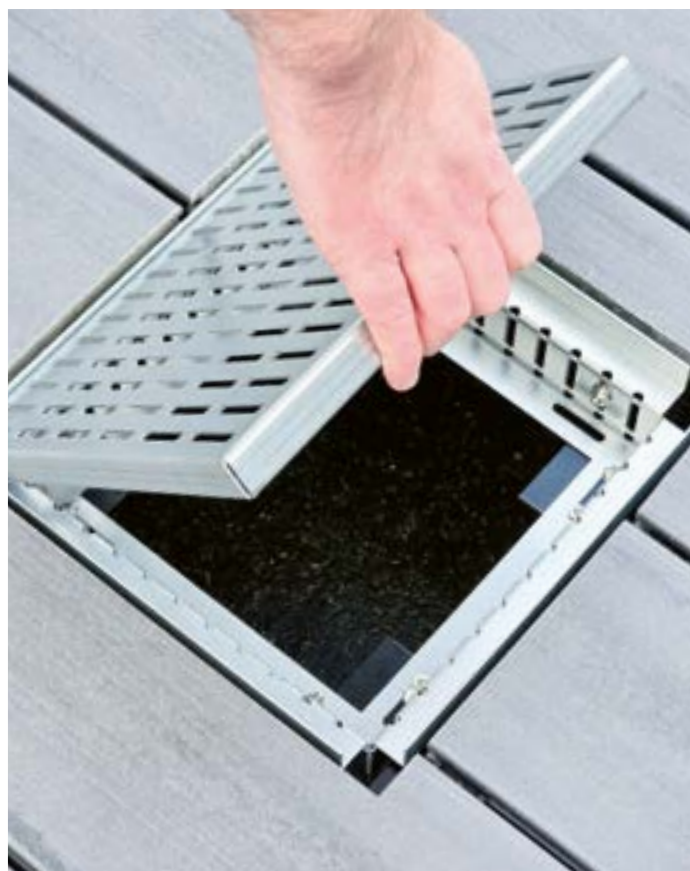
Abdeckblech in den montierten Kasten einlegen
