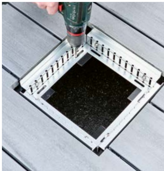
Revisionskasten einsetzen und an Windlastträger verschrauben
