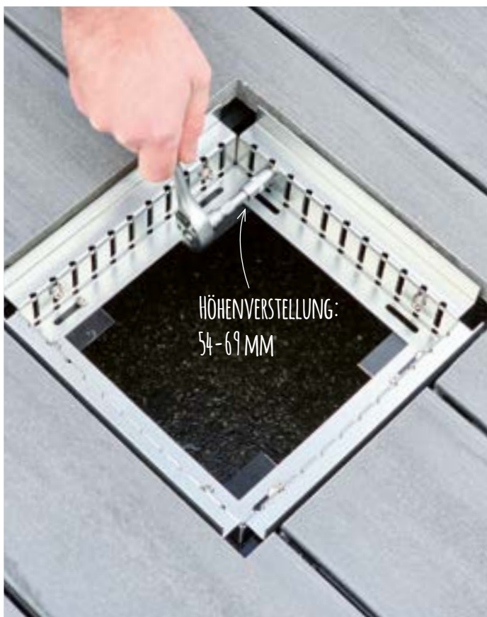
Höhe des Revisionskastens an den Terrassenbelag anpassen
