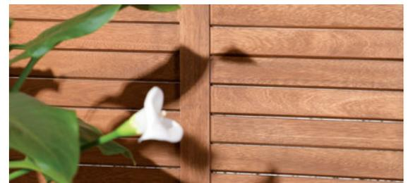
Die an der Unterseite leicht angeschrägten Lamellen erlauben - je nach Blickwinkel - eine leichte Durchsicht.
