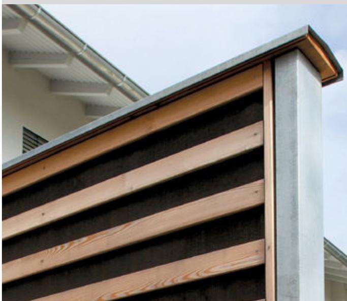
Ausführung mit Stahlpfosten
